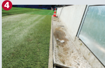
Le pourtour du stade De la tôle en alu qui menace de céder, au lieu d'acier inoxydable. Le gazon synthétique doit lui aussi être changé.
